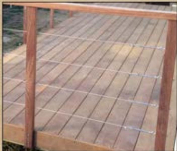
Garde-corps en câbles métalliques. Diamètre 6 mm. Tendeurs apparents.
